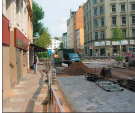
Bauarbeiten in der Brigittenstraße
